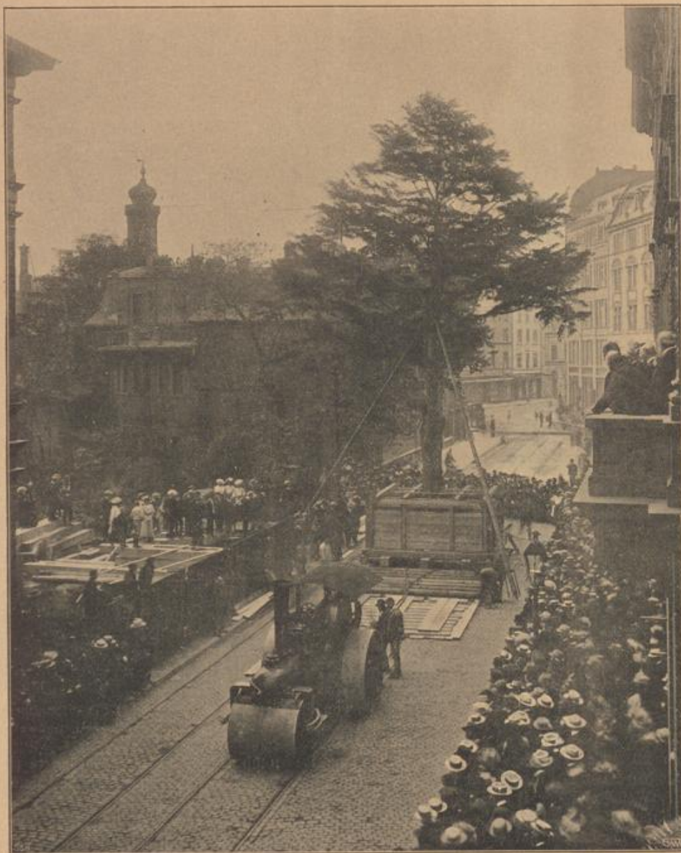
Abfahren der dreihundertjährigen Eibe mittelst Dampfwalze auf Bohlen und Rollen. Nach einer Aufnahme der Lichtdruckanstalt C. F. Fay, Frankfurt a. M., für die „Gartenwelt“ gefertigt.
