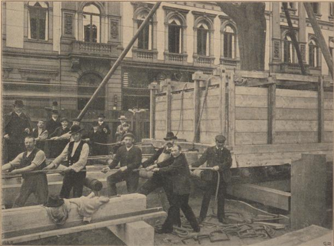
Fortbringen der Eibe von der Grube mit Rollen und Flaschenzügen.
